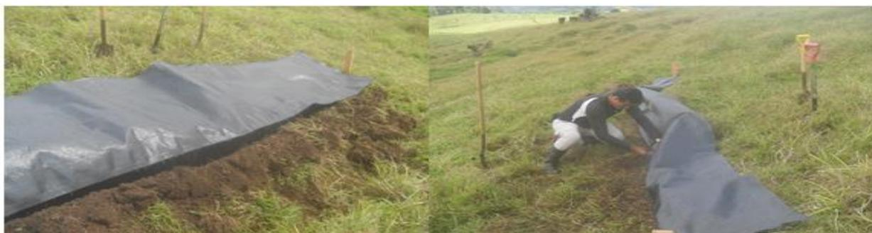
Posteriormente a acomodar y enterrar aproximadamente el 50% del geotextil en la zanja, la parte que queda sobre la superficie se extiende unos 15 cm en dirección de la pendiente, cubriendo el ancho de la zanja y seguidamente el sobrante se orientó y fijó de forma vertical. Para ello se utilizaron estacas de madera con una longitud de entre 80 y 100 cm. Estas se enterraron entre 30 a 40 cm de profundidad y colocaron a una distancia de aproximadamente 40 cm una de otra (Figura 11).
